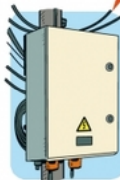
Щит уличного освещения
